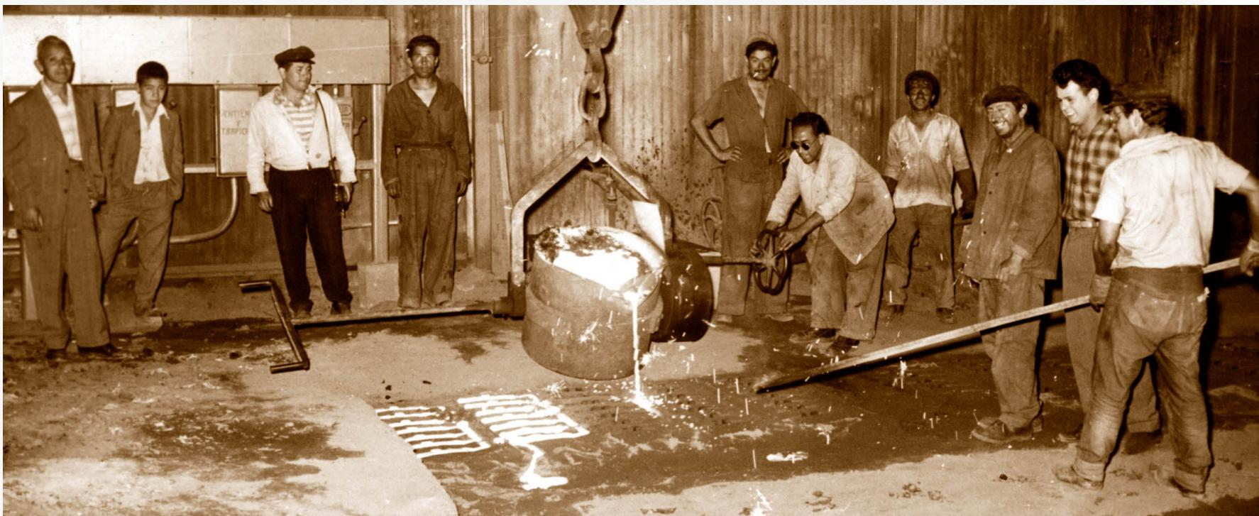
Taller de Maquinaria , para elaborar piezas fundidas y forjadas. Contaba con tornos, cepillos, taladros y fresadoras, incluida maquinaria movida con 70 motores eléctricos. También fue necesario disponer de secciones para mantener calderas, carrocería mecánica y de aire, cobres, electricidad, soldadura eléctrica y pintura.
